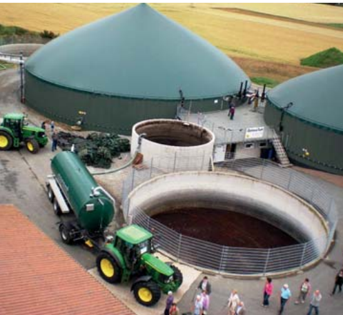
Blick auf die Biogasanlage JSJ Peckelsheim / Foto: Stephanie Fix
